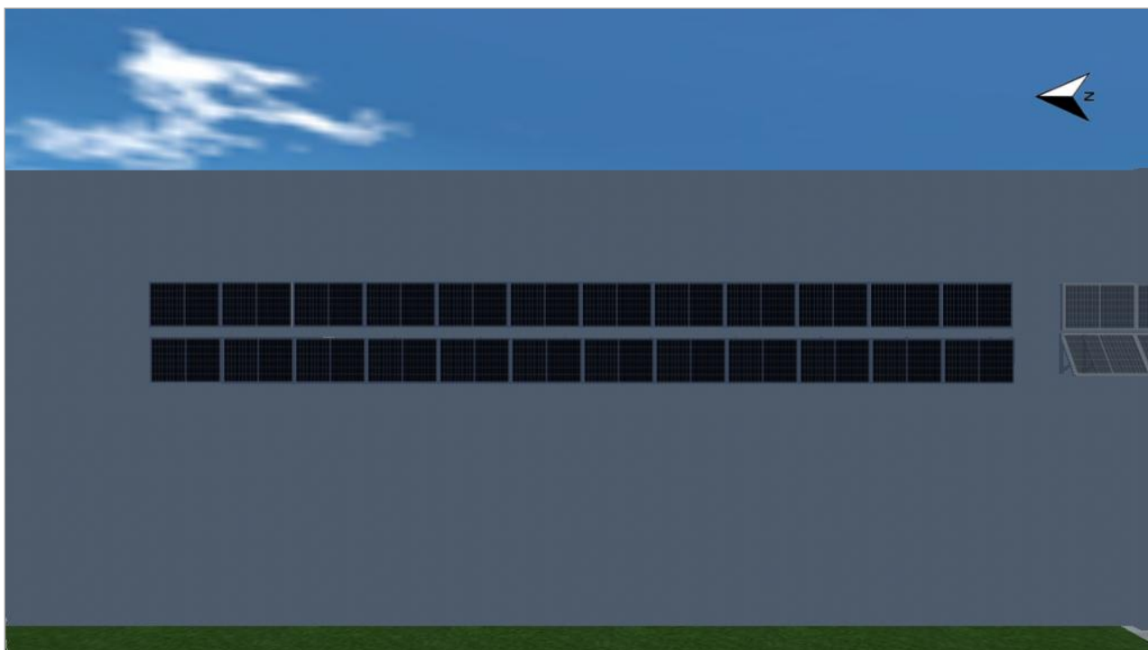
Ilustracja: 7. Powierzchnię modułu - Budynek 05-Fasada Zachód
